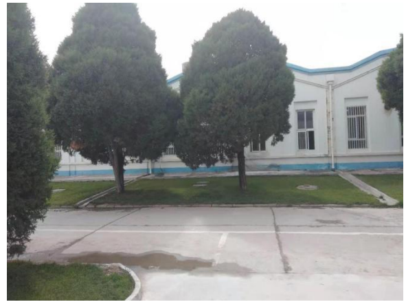
西侧厂区内道路
