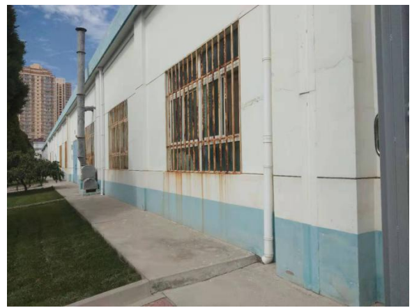
北侧已建探伤工作区
