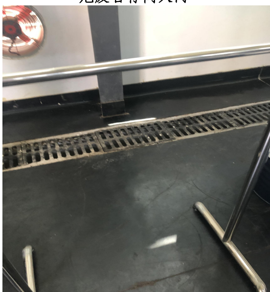
危废暂存间地面
